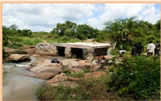
De brug is klaar!
