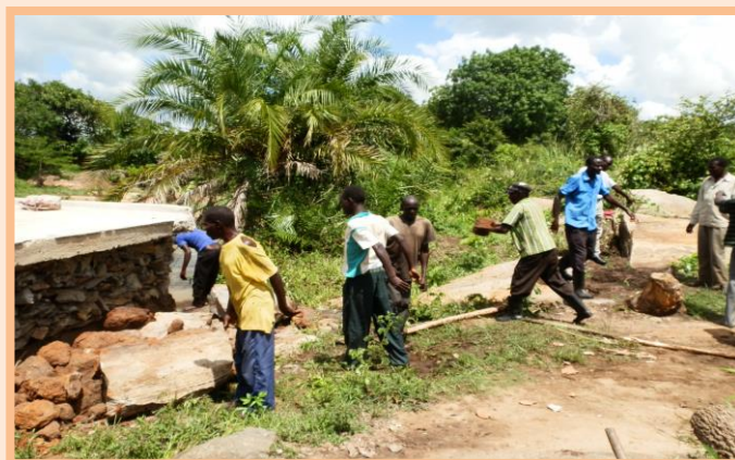
De weg wordt aangelegd.
